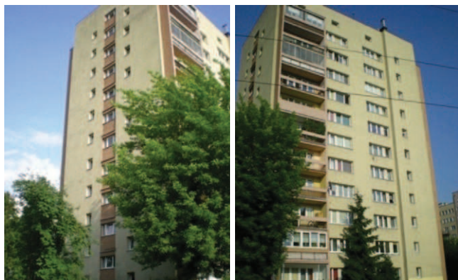
Rys. 1. Analizowany budynek – widok od strony północnej oraz zachodniej
