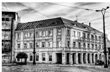
Rys. 9. Kamienica przy ul. Legionów 2 po remoncie
