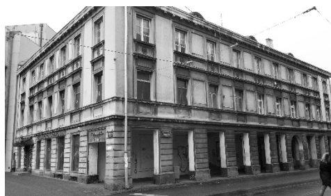
Rys. 8. Kamienica przy ul. Legionów 2 przed remontem
