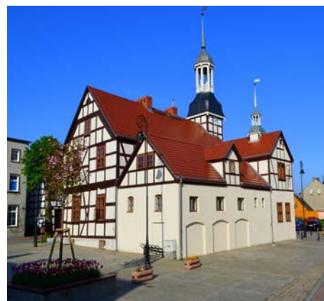
Ryc. 4. Rewitalizacja ratusza i jego otoczenia w Nowym Warpnie. Źródło: [22, fot. M. Tokarski]
