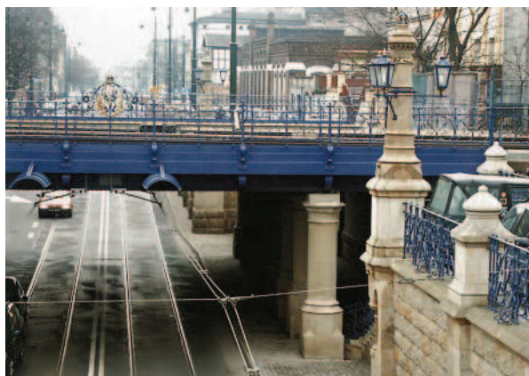
Wiadukt kolejowy z fragmentem murów oporowych i kolumnadą (Fot. I. Płuska)
