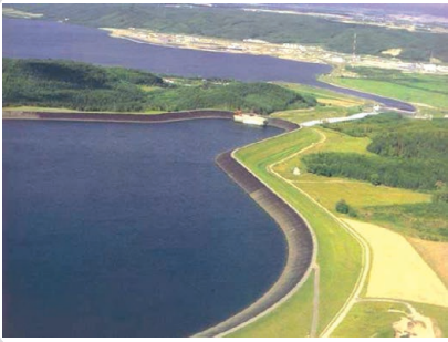
Fot. 10. Widok zbiornika górnego elektrowni szczytowo-pompowej, rurociągów, elektrowni i Jeziora Żarnowieckiego
