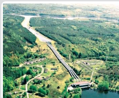
Fot. 9. Widok kanału otwartego, rurociągów i elektrowni wodnej Żydowo
