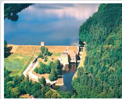
Fot. 1. Elektrownia wodna Łapino na Raduni
