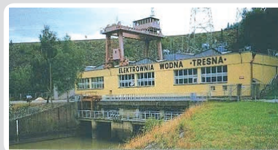
Fot. 6. Widok od strony wody dolnej elektrowni wodnej Tresna na tle zapory ziemnej
