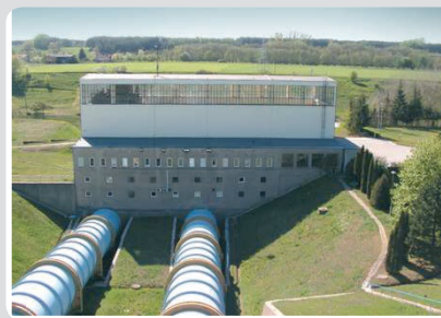
Fot. 5. Elektrownia wodna Koronowo. Widok dwóch rurociągów doprowadzających wodę do elektrowni
