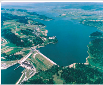
Fot. 8. Widok zapory Czorsztyn-Niedzica, wraz z przelewem powierzchniowym i elektrownią, oraz zbiornika
