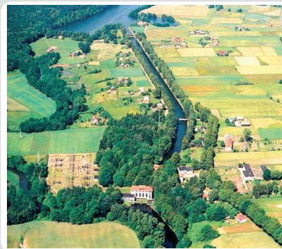
Fot. 2. Widok Jeziora Żurskiego z kanałem derywacyjnym i elektrownią wodną
