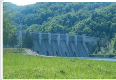
Fot. 4. Widok zapory Rożnów od strony wody dolnej. Widoczne przelewy zamykane segmentami i wyloty upustów dennych
