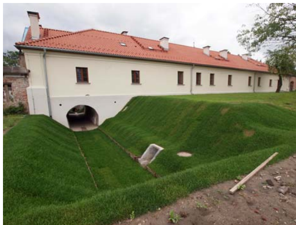
Ryc. 8. Wschodnia elewacja budynku barokowego z odnowionym kanałem i zrekonstruowanym końcowym odcinkiem koryta młynówki
