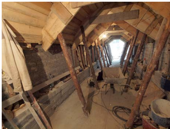
Ryc. 12. Wnętrze kanału pod budynkiem barokowym w trakcie przemurowywania ścian podłużnych; kolebka zabezpieczona krężyną i stemplami
