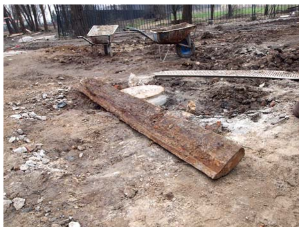
Ryc. 11. Drewniane kolki palisady posadowienia ścian kanału i deski zabezpieczające ich pas przydenny
