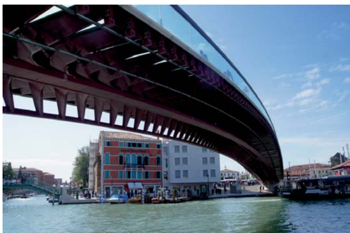
Fot. 4. Widok na przęsło łukowe Mostu Konstytucji w Wenecji
