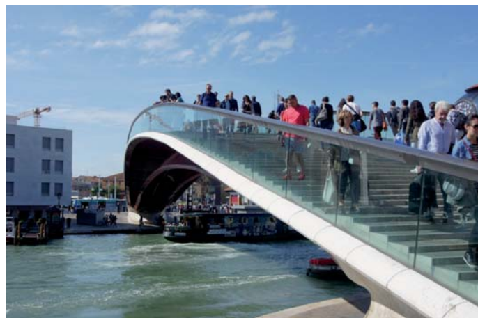
Fot. 5. Szklane schody i pomost w części zwornikowej pełniące rolę tarasów widokowych
