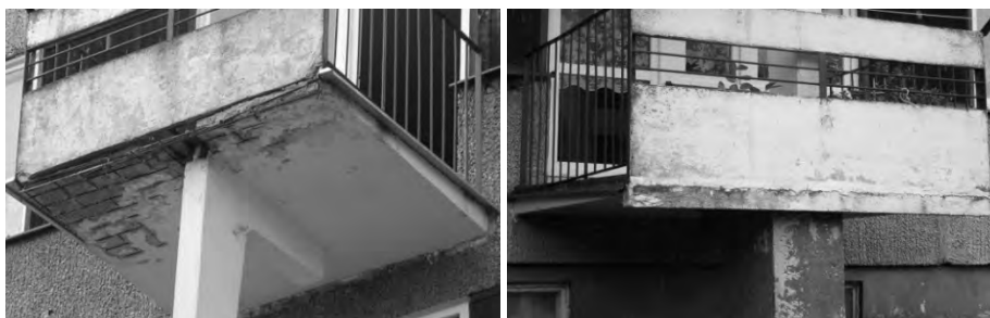
Rys. 2. Widok balkonów budynku wykonanego w systemie OWT-75 [fot. autora]
