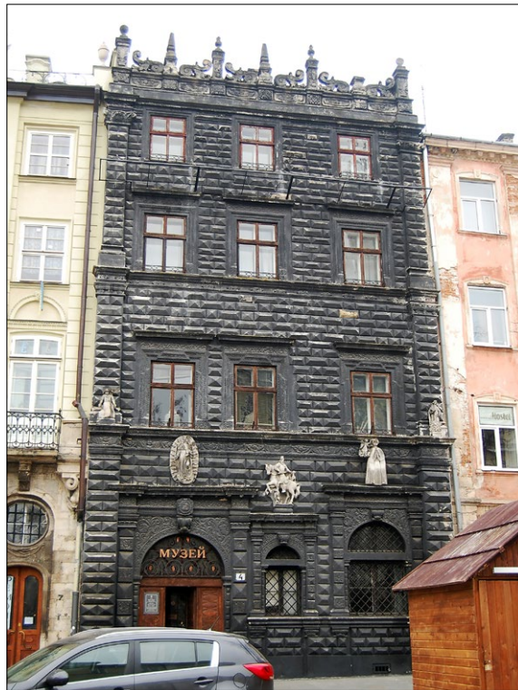
Fig. 1. Black House on Rynek Square in Lviv, view before the restoration, 2015; photo by O. Rybchynskiy. Рys. 1. Czarny Dom przy placu Rynkowym we Lwowie, widok przed renowacją, 2015; fot. O. Rybchynskiy.
