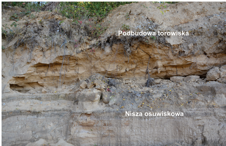
Fot. 2. Nisza osuwiskowa w piasku średnim – warstwa Ia Fot. 2. Landslide scar in middle sand – layer Ia
