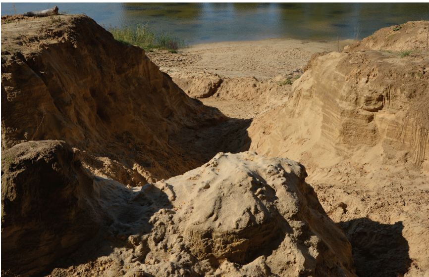
Fot. 5. Rozcięcia erozyjne w koluwium osuwiskowym Fot. 5. Detach surfaces in colluvium
