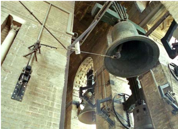
Ryc. 10-11. Napędy mechaniczne dzwonów w jednym z kościołów w Barcelonie
