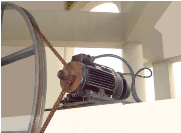
Ryc. 12. Fragment napędu łańcuchowego dzwonu Bogurodzica w Licheniu
