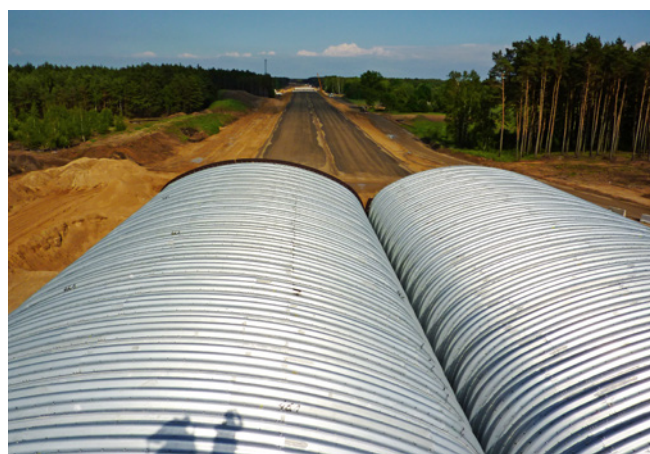
Ryc. 2. Przykład budowy mostu ekologicznego nad autostradą. Widoczne miejsca stykające się w części środkowej dwóch szeregów konstrukcji. Widoczne jest newralgiczne miejsce, którego właściwe odwodnienie powinno być szczególną troską projektanta i wykonawcy, a później także służb utrzymaniowych, fot. A. Wysokowski
