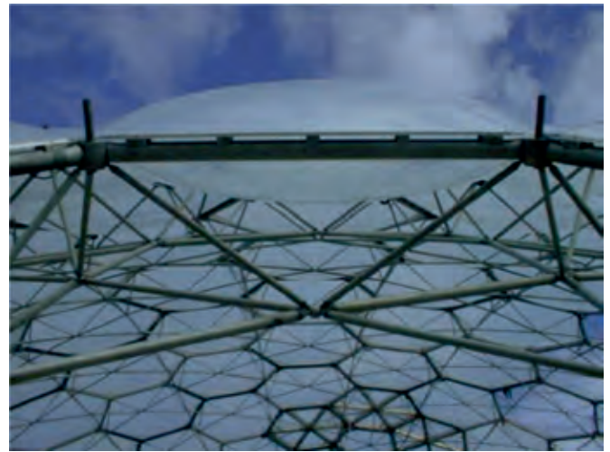
Rys. 4. Heksagonalna płyta wykonana z Tefzel'u ( www.studioseverini.com/DocumentiPDF/eden_project_english.pdf )
