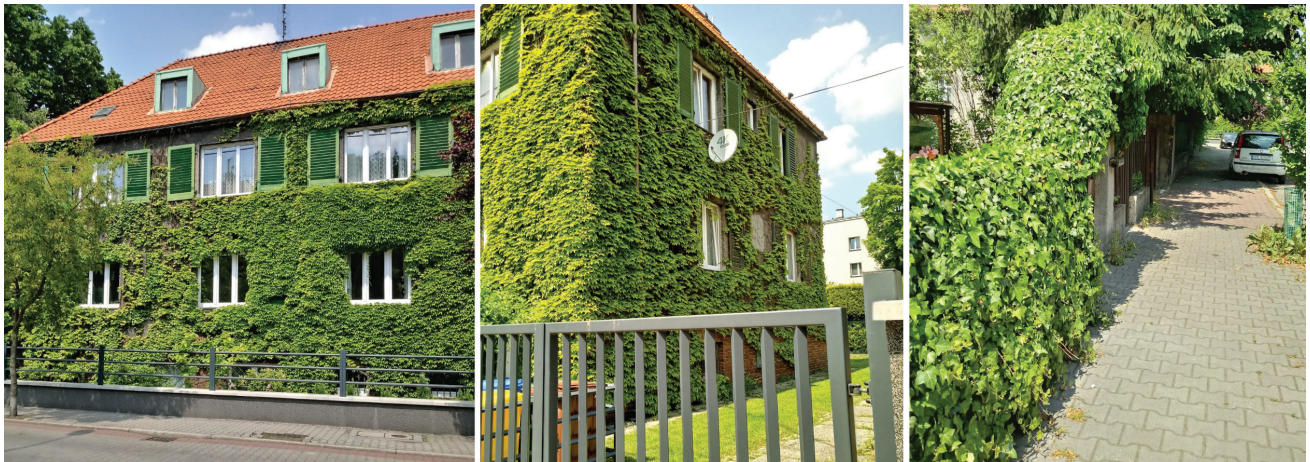
Fot. 2. Przykład naturalnej zielonej fasady oraz „zielonego” ogrodzenia – Bytom, Polska. Źródło: Piotr Wawrzyniak
