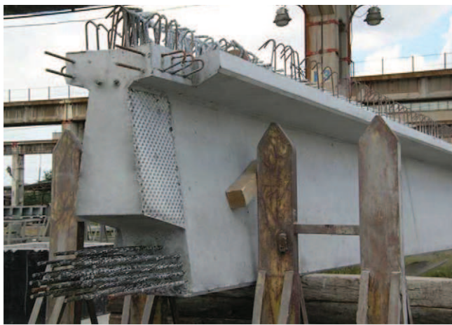
Rys. 2. Belka T po wyjęciu z formy [2]
