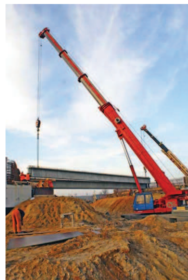
Rys. 4. Montaż ustroju nośnego [2]
