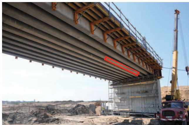
Rys. 6. Widok obiektu z zaznaczonym fragmentem belki podlegającym badaniu
