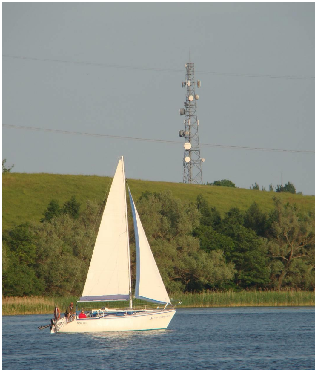
Fig. 2. A wireless telephone tower on the trail of the Great Masurian Lakes. Source: W. Gadomska Ryc. 2. Wieża telefonii komórkowej na szlaku Wielkich Jezior Mazurskich. Źródło: il. W. Gadomska
