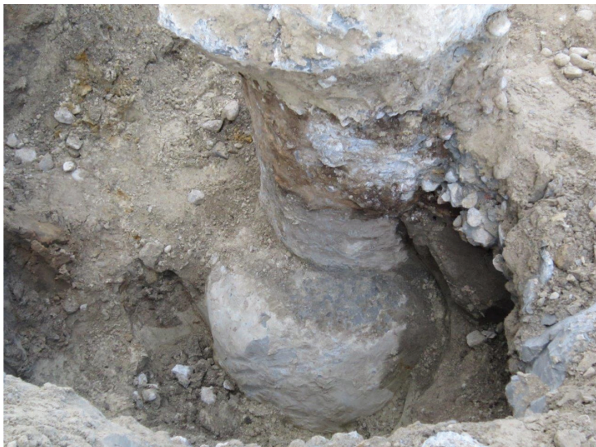
Rys. 2. Widok odkopanego trzonu pala z podstawą poszerzoną iniekcją strumieniową
