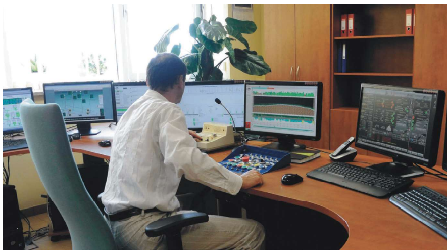
Rys. 15. Stacja kontrolna kompleksu strugowego na Stefanowie
