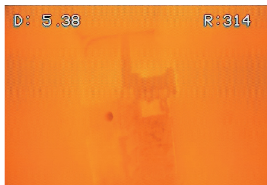
Rys. 8 Widok wnętrza jednego z ocenianych kanałów grzewczych uzyskany za pomocą urządzenia Videofil z wysokotemperaturową sondą z osiowym polem widzenia
