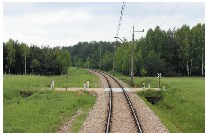
Fot. 2. Szlak Brzustów–Dęba Opoczyńska na linii nr 22 po naprawie nawierzchni (zwiększenie prędkości maksymalnej do 120 km/h)
