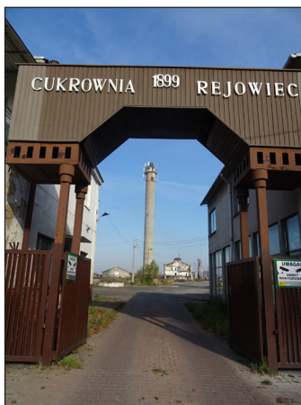
Fot. 5. Brama wjazdowa na tereny cukrowni Rejowiec Photo 5. Entry gate to the sugar factory Rejowiec
