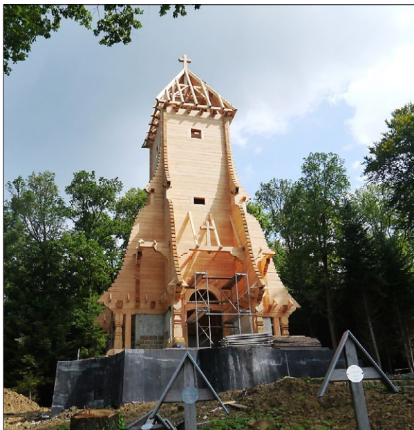
Ryc. 5. Kaplica w trakcie prac budowlanych w roku 2014; fot. D. Rozbicka 2014.
