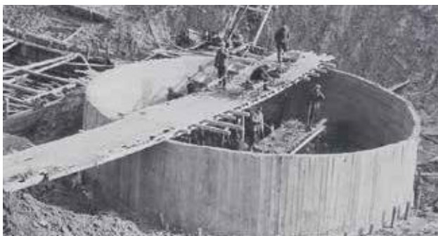
Fot. 1. Budowa reaktora EWA (Źródło: NCBJ) Photo 1. Construction of the EWA reactor (Source: NCBJ)
