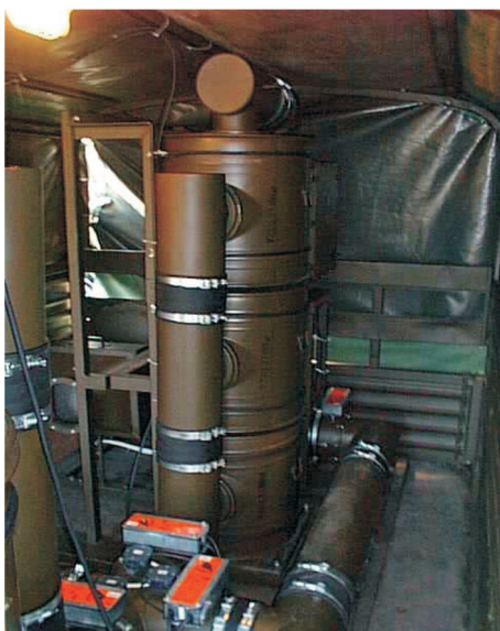
Rys. 4.3. a) Zestaw UFW-900 z systemu ochrony zbiorowej typu lekkiego. Urządzenie realizuje oczyszczanie powietrza metodą trzystopniową: I stopień — filtr zgrubnego odpylania do zatrzymywania pyłów i aerozoli o wielkości cząstek powyżej 5 \mu\text{m} ; II stopień — przedfiltr PF-1000 do zatrzymywania aerozoli stałych i ciekłych o wielkości cząstek powyżej 0,3 \mu\text{m} ; III stopień — filtropochłaniacz FP-300P do zatrzymywania aerozoli i par bojowych środków trujących i substancji biologicznych oraz chloru i amoniaku. b) Układ sterowania i kontroli urządzenia UFW-900-2C systemu: 1) automatyczny gazosygnalizator „ALERT-2”, 1a - wlot powietrza - kontrola atmosfery — I tor pomiarowy sygnalizatora; 1b — kontrola skażenia powietrza za układem filtrowentylacji — II tor pomiarowy sygnalizatora; 2 — tablica przyrządów pomiarowych (przepływomierze i manometry różnicowe); 3 — tablica sterownicza z falownikami
