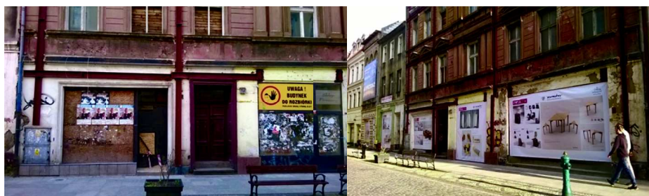
Rys. 3, 4. Studencka akcja „oswajania” opuszczonych lokali handlowych przy ulicy Długiej – stan przed „maskowaniem” i po. Niepodjęty przykład „prototypowania” (materiały własne autorki)
