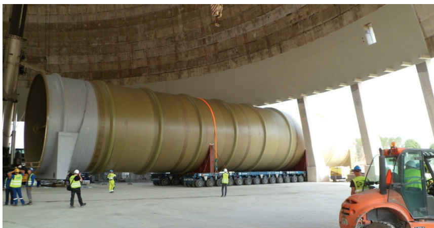
Rys. 11. Transport kanału do chłodni kominowej
