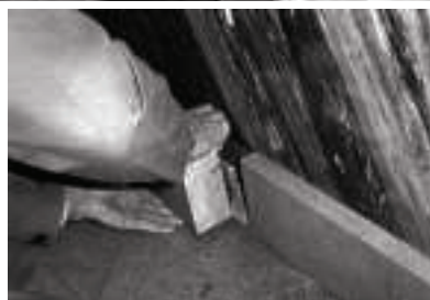
Ryc. 16. Rekonstrukcja oblicowania cokołu kamieniem – piaskowcem Fig. 16. Reconstruction of the pedestal sandstone facing
