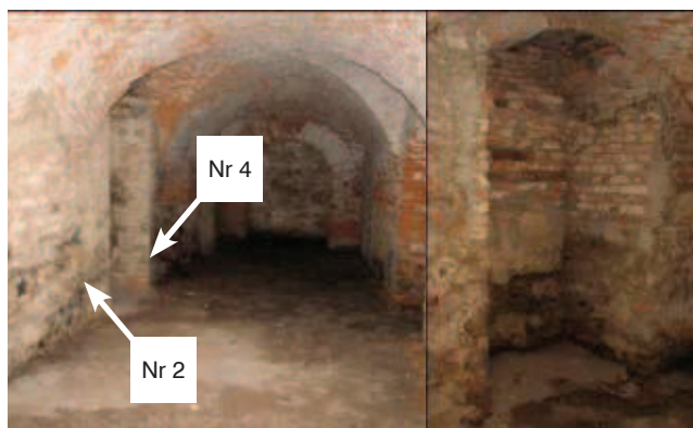
Rys. 5. Ogólny widok ścian piwnicy i usytuowanie miejsc pobrania próbek
