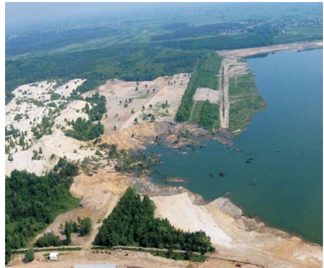
Ryc. 10. Osuwisko powstałe na zachodniej skarpie zbiornika wodnego „Piaseczno”. Fot. z arch. Kopalnia Siarki „Machów” S.A. Fig. 10. The landslide on western escarpment of "Piaseczno" water reservoir. Photo from Kopalnia Siarki "Machów" S.A. archive
