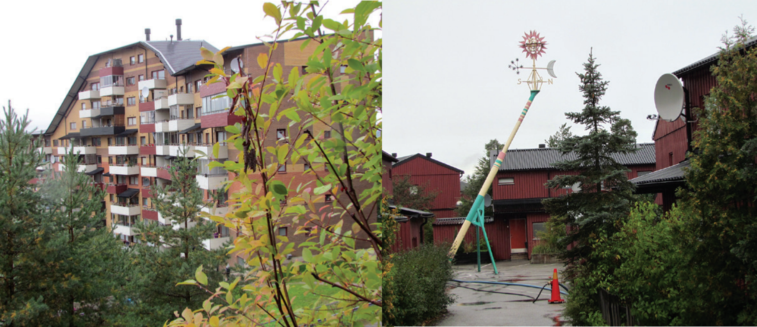
il. 2, 3. Varby – osiedle Myrstuguvagen zlokalizowane na skalistym terenie, w odległości ok. 10 km od centrum Sztokholmu, w dogodnym zasięgu przystanku metra. Oferuje wysoki standard środowiska mieszkaniowego przy utrudnionym dostępie samochodem (garaże zlokalizowane na obrzeżach). Architekt Ralph Erskine, 1985 (fot. K. Bieda) / Varby – Myrstuguvagen neighborhood sited on a rocky area 10 km from Stockholm city centre, within walking distance to metro station. Offers high quality housing environment with restricted car access (garages located on the perimeter). Ralph Erskine, 1985.
