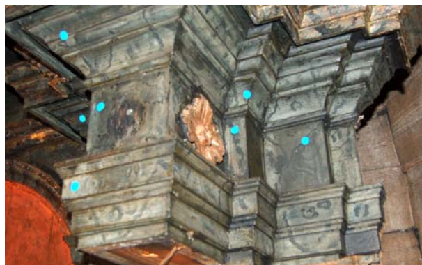
Ryc. 2. Żyłkowanie w strefie gzymsu. Polichromia zawiera smaltę, która korodowała, tworząc szaro-zielonkawe zacieki
