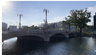
Fot. 10. Most Pomorski Południowy w trakcie prac remontowych – 12.08.2022; źródło: fot. autora
