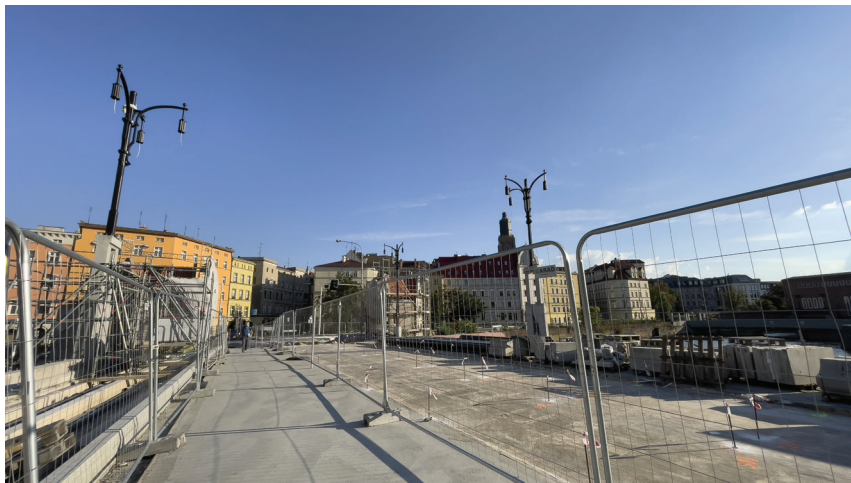
Fot. 14. Prace remontowe prowadzone na moście Pomorskim Południowym, stan na 12.08.2022; źródło: fot. autora
