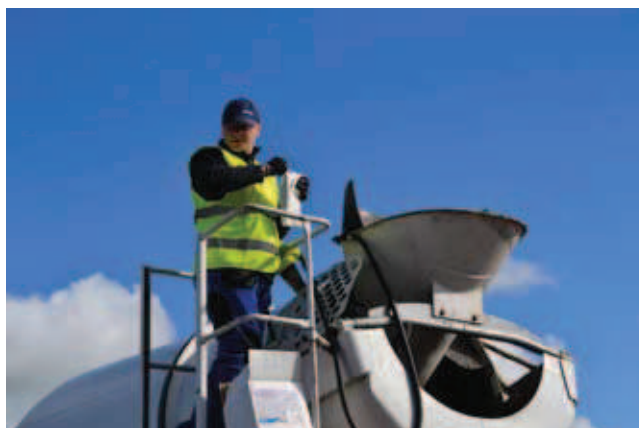
Rys. 2. Dozowanie preparatu do mieszalnika betonowozu
