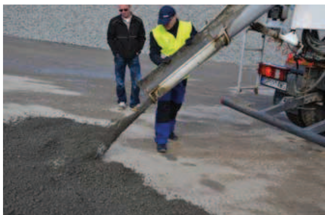
Rys. 3. Wygląd granulatu powstałego po utylizacji mieszanki: a) bezpośrednio po rozładunku, b) po 24 godzinach dojrzewania
