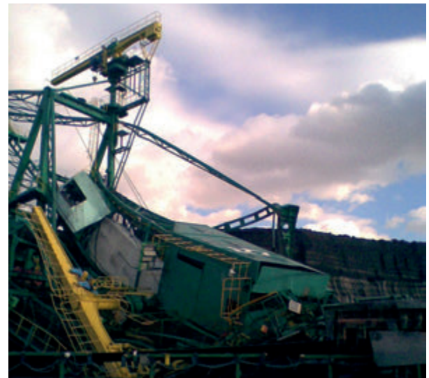
Fig. 3. Disaster of BWE KWK 1400 at lignite open pit mine Turów [7] Rys. 3. Katastrofa koparki kołowej KWK 1400 w KWB Turów [7]
