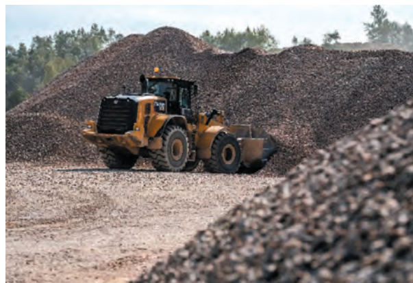
Rys. 17. Ładowarka podczas prac porządkowych
