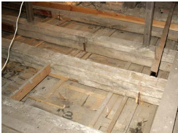
Ryc. 10. Strop płaski widziany od góry. Widoczne belki i pułap ramowo-płycinowy od góry, fot. ks. W. Dokurno
