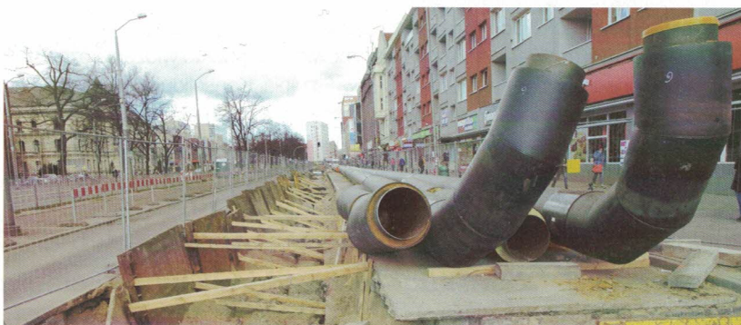
2014 r. Modernizacja sieci ciepłowniczej, Al. Niepodległości, Szczecin
