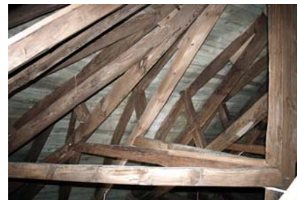
Rys. 44. Fragment naprawionej konstrukcji pseudokopuły
