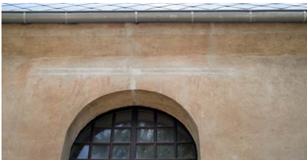
Rys. 49. Uzupełniony tynk na wzmocnionym łuku nadokiennym
