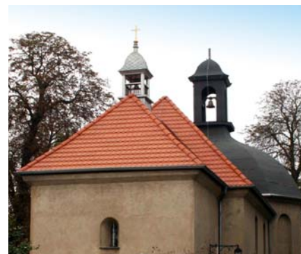
Rys. 45. Pseudokopuła i hełm pokryte termozgrzewalną papą podkładową
