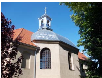
Rys. 46. Nowe pokrycie cynkowe pseudokołpę i hełmu nad ośmioboczną nawą kościoła Fig. 46. New zinc-titanium covering of pseudo-dome and helmet over the octagonal nave
