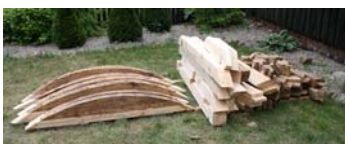
Rys. 41. Nowe i naprawione elementy konstrukcji pseudokopuły
