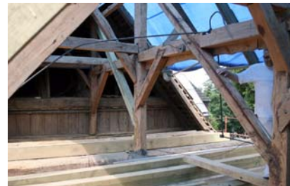
Rys. 36. Nowe belki stropowe i pierwotna ściana stolcowa nad prezbiterium
