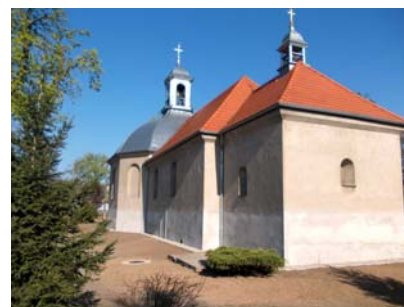
Rys. 52. Kościół pw. św. Idziego w Czerwonej Wsi. Widok obiektu i otaczającego terenu od strony południowo-wschodniej po zakończeniu prac rewaloryzacyjnych
