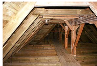
Rys. 14. Widok poddasza nad prezbiterium Fig. 14. Attic over the chancel
