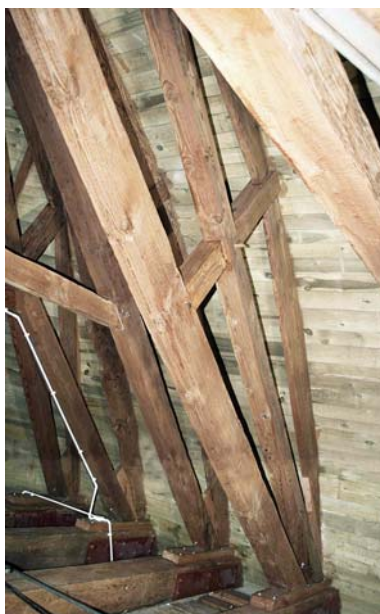
Rys. 11. Zastrzały i krążyny pseudokopuły Fig. 11. Struts and centering frames of the pseudo-dome
