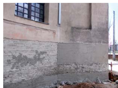
Rys. 51. Wykonywanie tynku renowacyjnego Fig. 51. Renovative plastering
