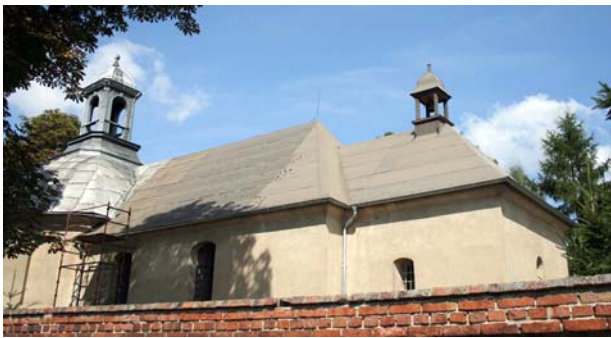
Rys. 38. Nowe dachy nad zakrystią i prezbiterium pokryte termozgrzewalną papą podkładową
