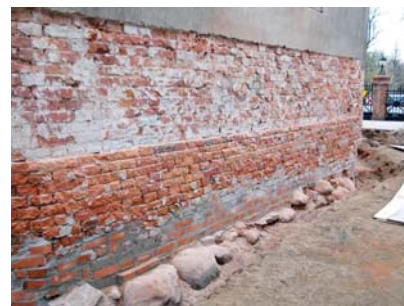
Rys. 50. Naprawiona ściana ośmiobocznej nawy Fig. 50. Repaired wall of the octagonal nave
