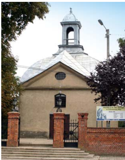
Rys. 1. Kościół pw. św. Idziego w Czerwonej Wsi. Widok od strony zachodniej przed wykonaniem prac remontowych
