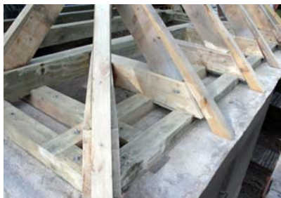
Rys. 32. Fragment odtworzonych belek podwalinowych i więźby nad zakrystią
