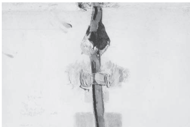
Rys. 3. Przemieszczenie i spękanie ściany
