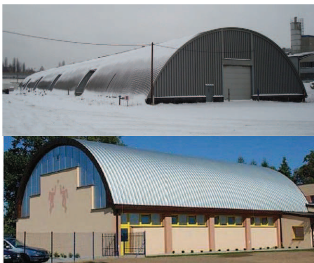
Rys. 3. Hala oraz zadaszenie w technologii ABM 120
