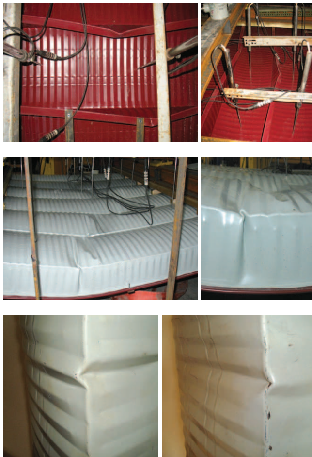
Rys. 6. Formy zniszczenia paneli ABM
