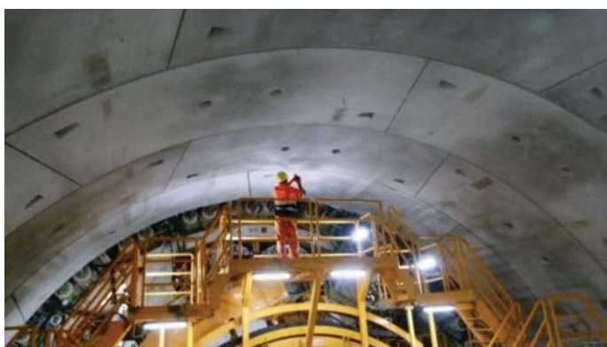
Rys. 15. Montaż betonowych segmentów obudowy [26]
