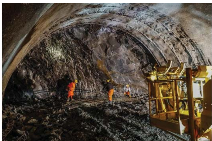
Rys. 11. Wykonywanie obudowy wstępnej [24]
