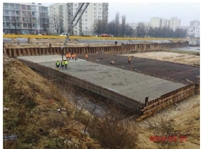
Rys. 7. Betonowanie stropu tunelu [21]
