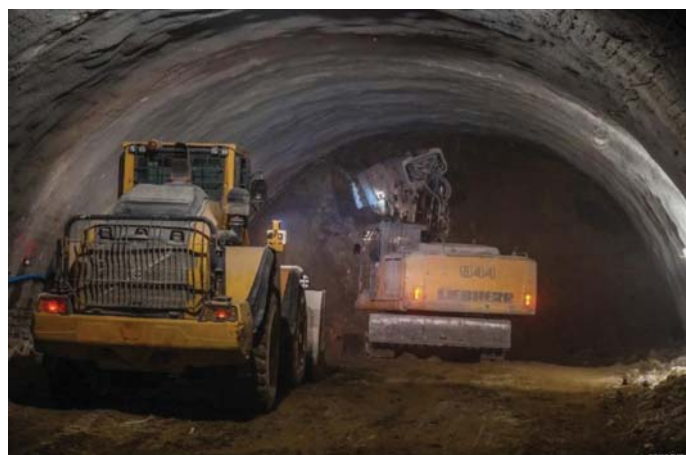
Rys. 10. Mechaniczne drążenie tunelu [24]
