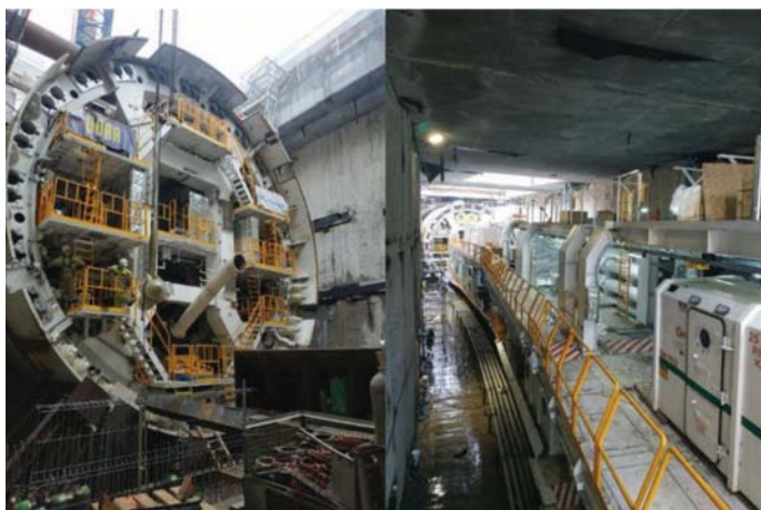
Rys. 14. Komora startowa – montaż tarczy TBM [26]
