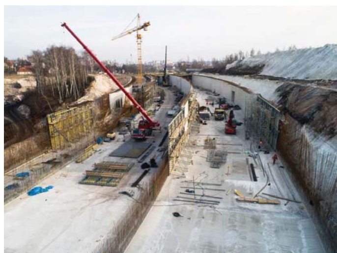
Rys. 17. Budowa tunelu w wykopie otwartym – betonowanie ścian [27]
