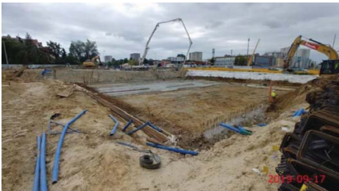
Rys. 6. Układanie warstwy betonu wyrównawczego pod płytę stropową [21]
