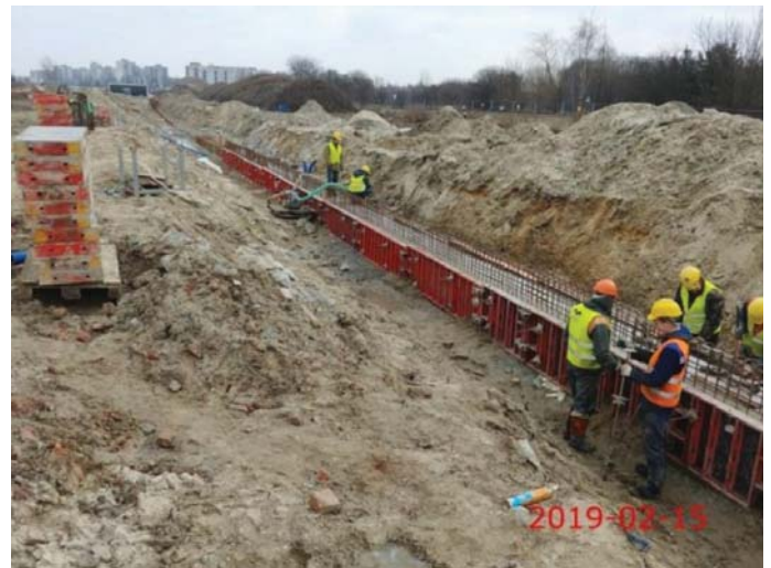
Rys. 5. Zbrojenie i deskowanie wieńców ścian szczelinowych [21]
