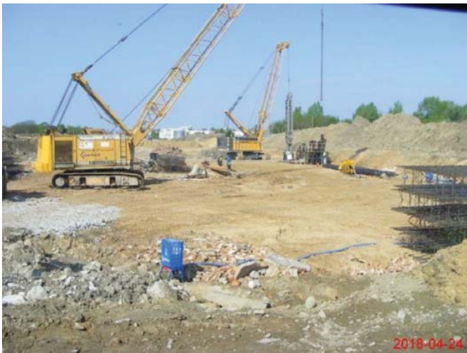
Rys. 4. Wykonywanie ścian szczelinowych [21]
