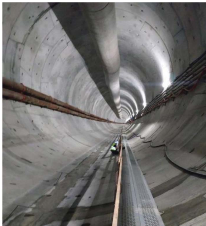
Rys. 16. Obudowa tunelu w Świnoujściu [26]
