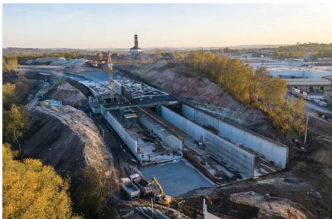
Rys. 18. Budowa tunelu w wykopie otwartym – betonowanie stropów [27]
