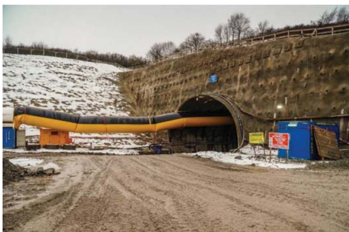
Rys. 9. Wzmocnienie portalu tunelu [24]
