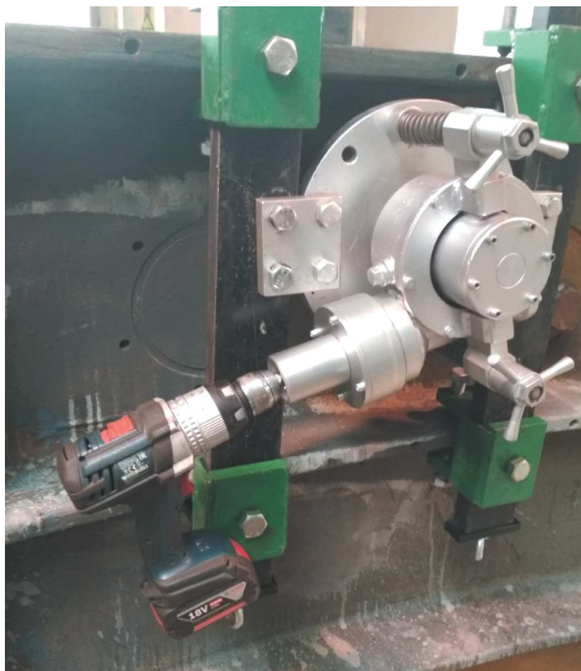
Rys. 10. Frezarka zamocowana do obudowy tubingowej wraz z wiertarko-wkrętarką przekazującą napęd
