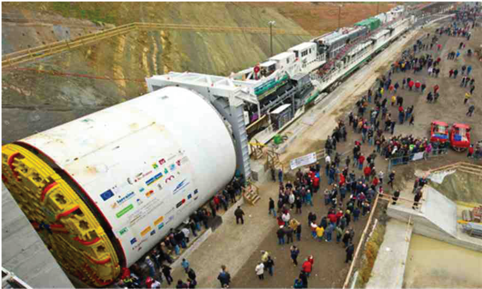
Fot. 6. Przygotowana maszyna ro rozpoczęcia pracy – widok na całą maszynę TBM
