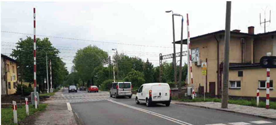
Fot. 1. Przejazd kolejowy kategorii A
