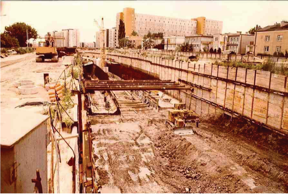
Fot. 4. Budowa tunelu przed stacją Służew
