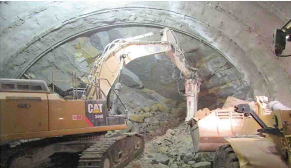
Fot. 5. Prace przy budowie tunelu na Zakopiance
