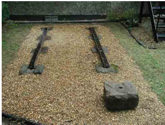
Rys. 15. Prymitywne torowisko z szynami Carre'a
