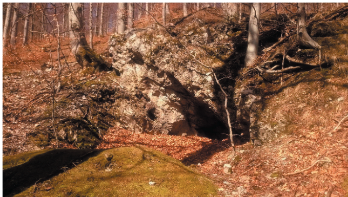
Ryc. 13. Wlot sztolni nr 27 (fot. A. Marek), stan z dnia 23.10.2011 r. Fig. 13. Entrance of adit 27 (photo. A. Marek), condition as for 23.10.2011
