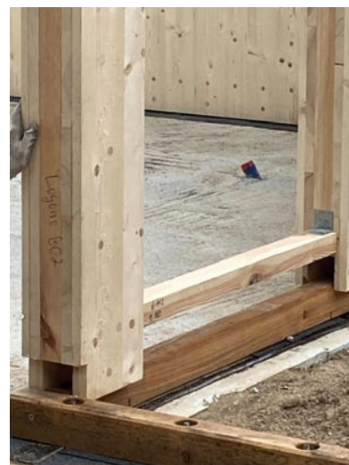
Rys. 6. Elementy prefabrykowane w technologii Holz100-Thoma w montażu
