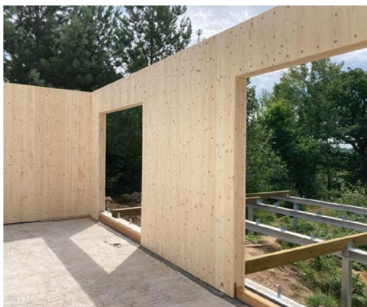
Rys. 4. Montaż elementów ściennych z drewna kijeżycowego
