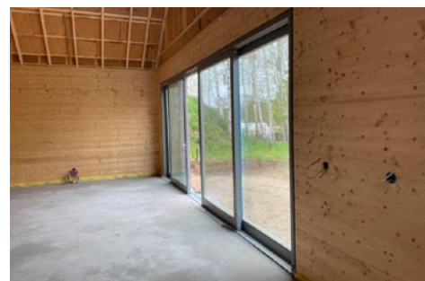
Rys. 9. Dom w stanie surowym zamkniętym
