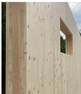
Rys. 3. Przykład ściany litej z drewna kijeżycowego
