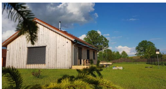
Rys. 10. Realizacja domu jednorodzinnego z drewna księżycowego, województwo dolnośląskie
