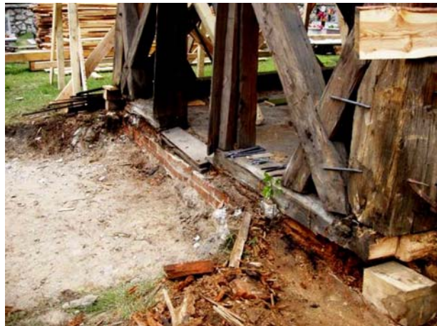
Ryc. 8. Otynkowane mury fundamentowe wraz z obróbką blacharską – rozwiązanie zgodne ze sztuką budowlaną, lecz sprzeczne z kanonami sztuki konserwatorskiej (kościół pw. Najświętszej Marii Panny w Szalszy z XVII w.)
