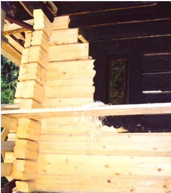
Ryc. 11. Wymiana uszkodzonych bali ścian – kaplica pw. św. Jadwigi Śląskiej w Wiśle Czarnem Fig. 11. Replacement of damaged walls elements in the chapel of St. Hedwig in Wisła Czarnem
