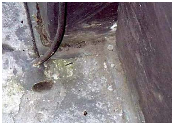
Ryc. 10. Stan poziomej izolacji z blachy miedzianej po 15 latach eksploatacji – kościół pw. św. Michała Archanioła w Katowicach (XVI w.) Fig. 10. Condition of horizontal insulation from copper sheet after 15 years of service – church of St. Michael the Archangel in Katowice (The sixteenth century)
