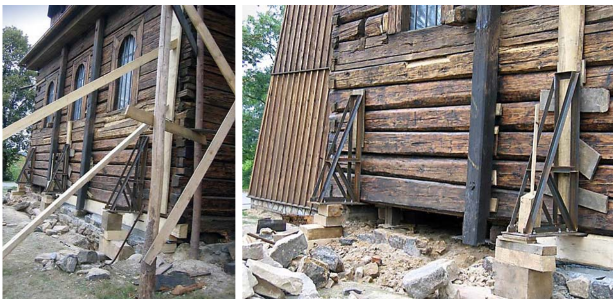
Ryc. 7. Wymiana belki podwalinowej – kościół w Żernicy
