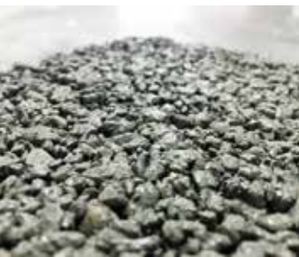
Powierzchnia górna ułożonej warstwy przepuszczalnej podbudowy
