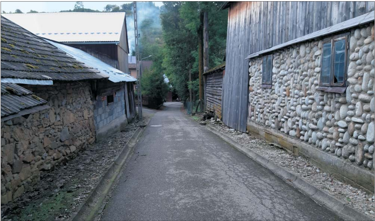
Ryc. 12. Kamienne ściany budynków gospodarczych przy drodze w Trybszu wykonane z brył piaskowca (z lewej strony) i granitowych otoczków (z prawej) – potencjalny punkt geoturystyczny
