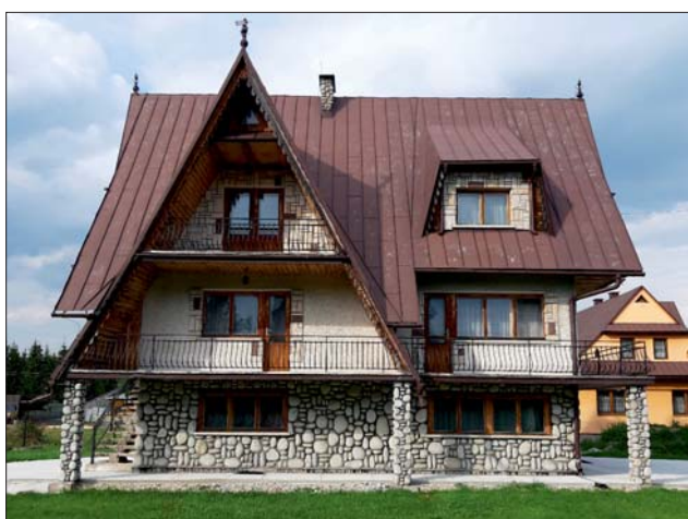
Ryc. 9. Podhalański dom mieszkalny w Podczerwone z podmurówką wykonaną z granitowych otoczaków Fig. 9. Podhale residential house in Podczerwone with a foundation made of granite pebbles
