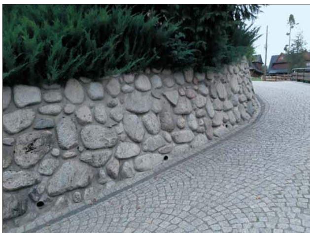
Ryc. 7. Mur oporowy z granitowych otoczaków w Małym Cichem Fig. 7. A retaining wall made of granite pebbles in Małe Ciche
