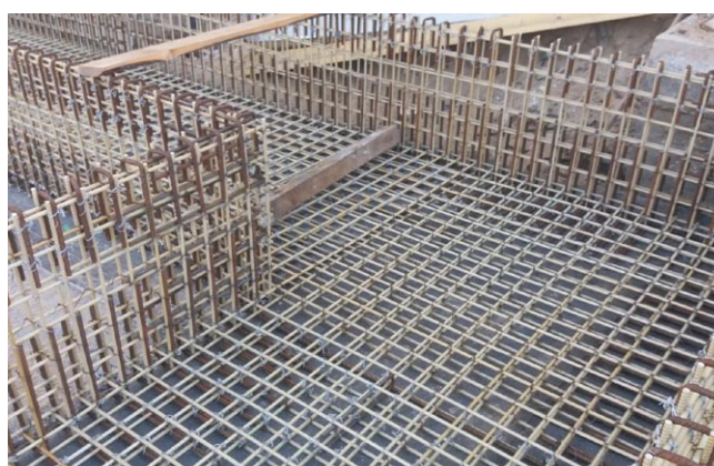
Rys. 3. NAFTOPORT Gdańsk – zastosowanie prętów kompozytowych w budowie kanałów technologicznych [11]
