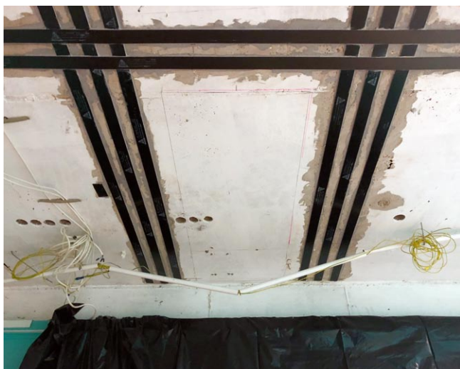
Rys. 1. Miejscowe wzmocnienie stropu za pomocą taśm z włókna węglowego – CFRP [10]
