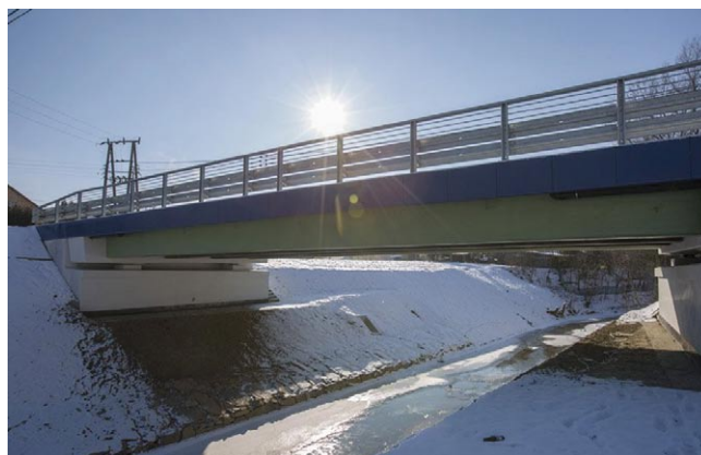
Rys. 2. Pierwszy w Polsce most drogowy z kompozytów FRP – w Białej pod Rzeszowem [5]
